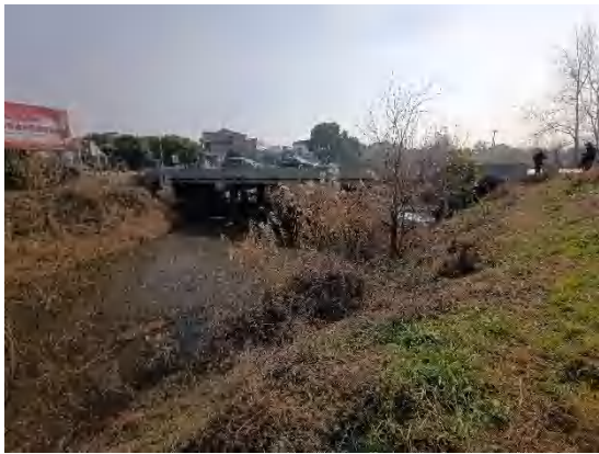
桥梁现状立面
