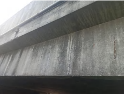
主梁混凝土破损露筋 表 4-1 上部承重构件病害表
