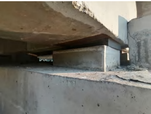
支座移位、老化开裂
