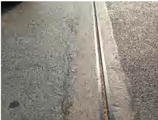
桥头未设置防撞护栏、伸缩缝堵塞、锚固区及接缝处破损
