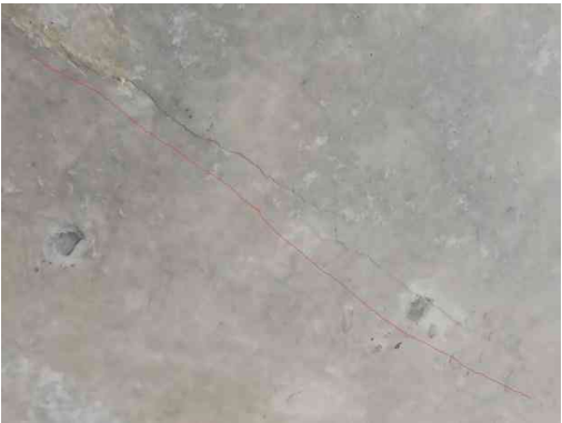
引桥空心板底纵向贯通裂缝
