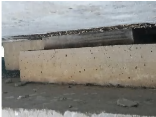
支座移位、老化开裂
