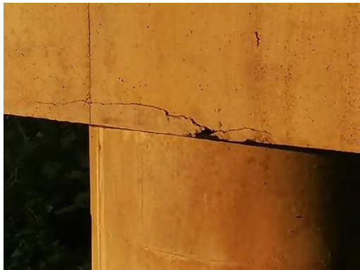
桥墩盖梁破损露筋
