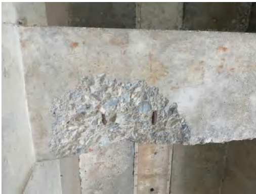
横隔板底部破损露筋
