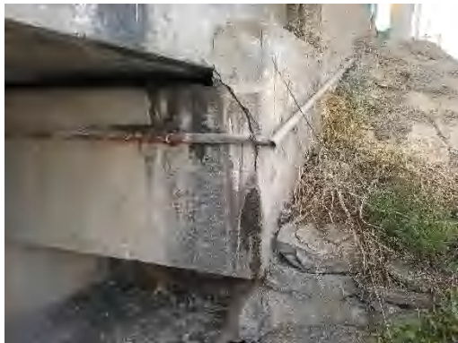
桥台挡块斜向开裂
