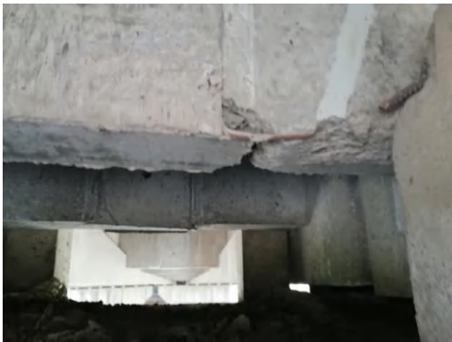
横隔板底部破损露筋
