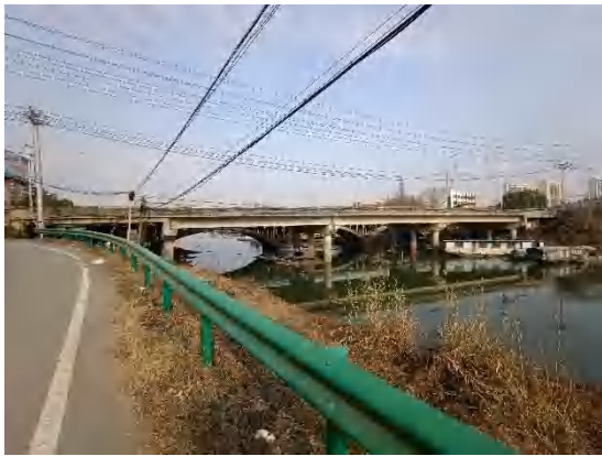
桥梁现状立面
