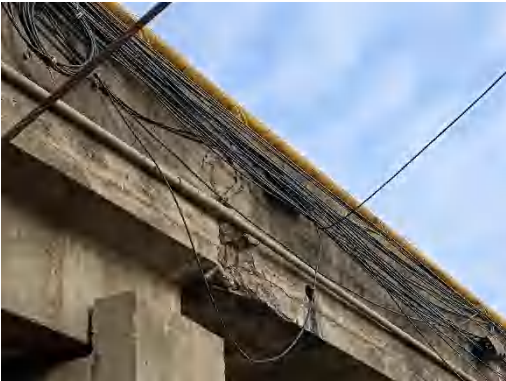
主梁混凝土破损露筋 表 4-1 上部承重构件病害表
