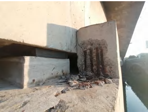
桥墩盖梁破损露筋
