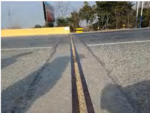
桥头未设置防撞护栏、伸缩缝堵塞、锚固区及接缝处破损
