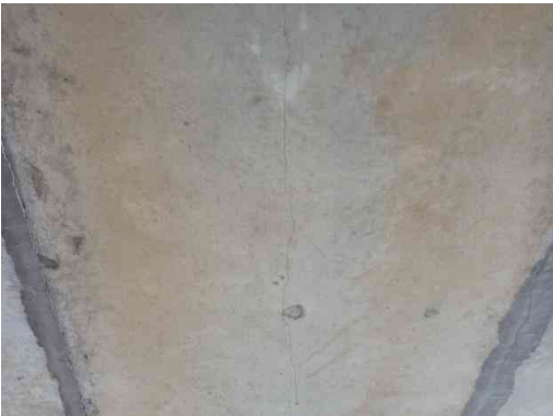
引桥空心板底纵向贯通裂缝
