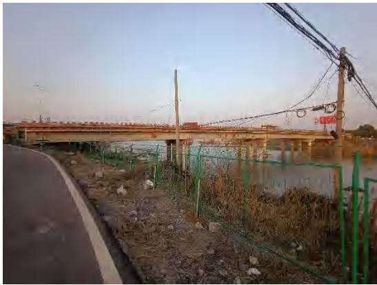
桥梁现状立面
