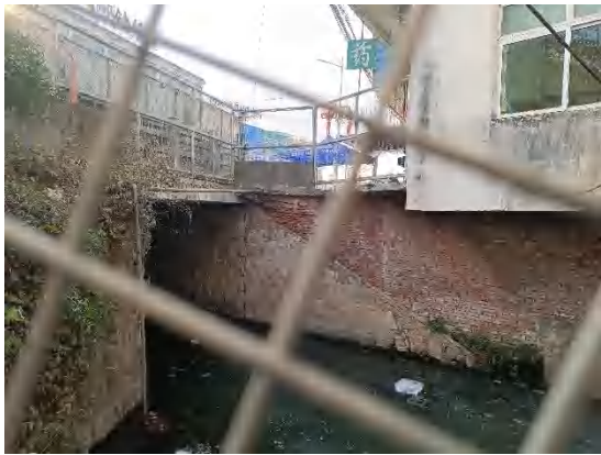
桥梁现状立面
