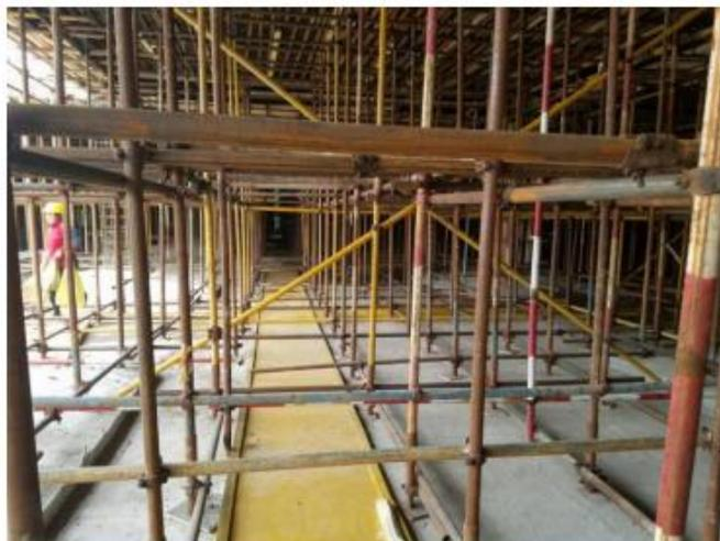
立杆采用槽钢做底座，剪刀撑设置
