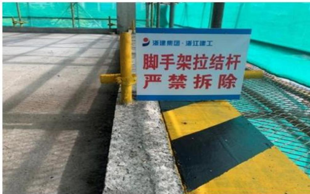
1. 架体拉结钢管与主体拉结首选采用主体结构预埋螺栓形式（左图）（如当地主管部门有另外要求的，按当地主管部门要求执行）。
