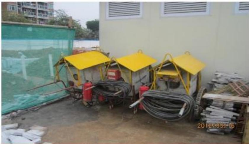
电焊机二次空载降压保护器及防雨罩
