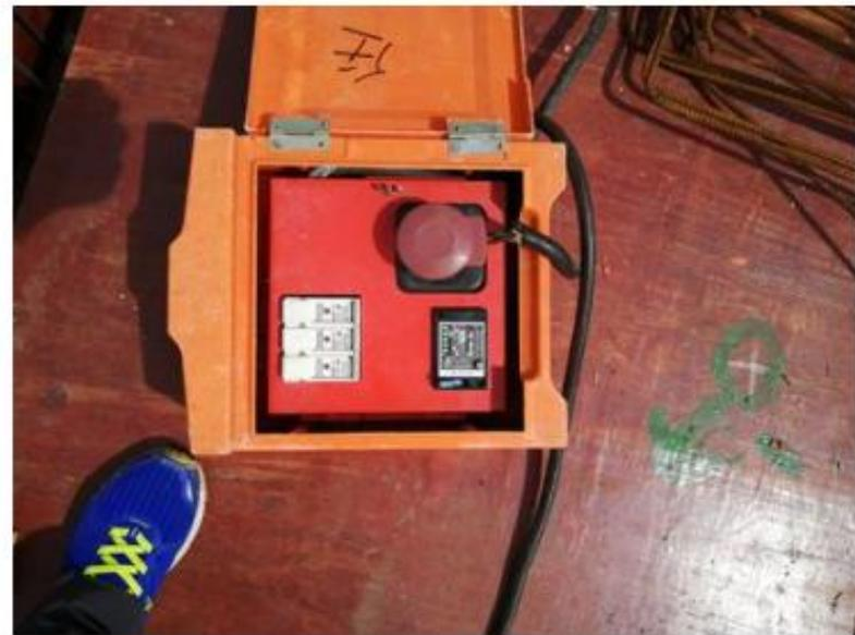
1. 二级箱出线接线头需采用防爆工业接座（左图）。
