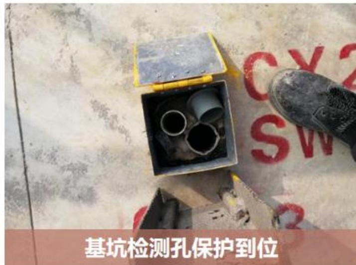
1. 基坑检测孔必须做好成品保护，要求采用金属盒子做保护盒，同时与地面固定牢固；检测管管口需做好管盖保护。
