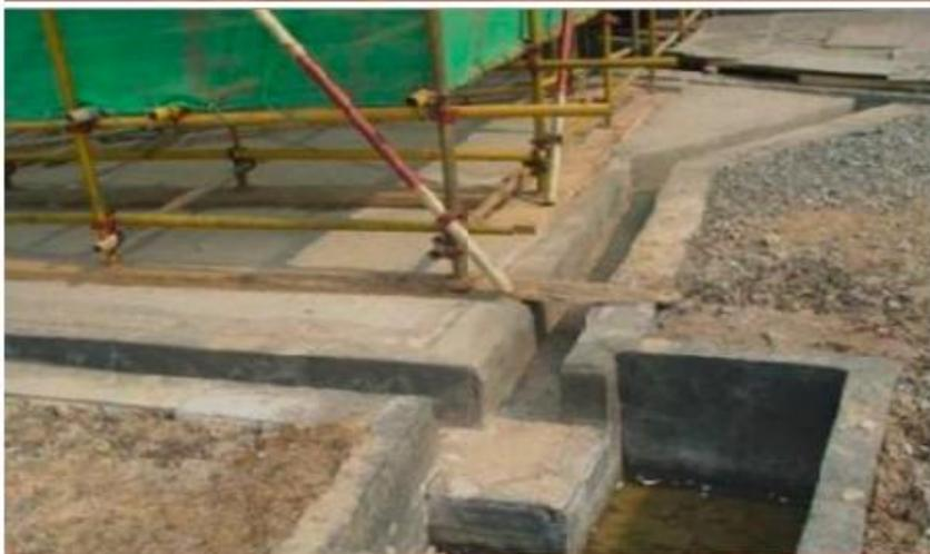
落地架基础周边设置排水沟和集水井
