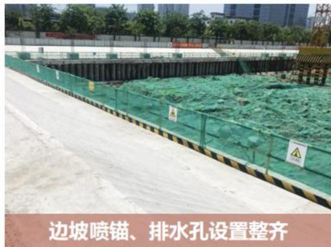
1. 基坑边需设置排水沟（必须设置在止水帷幕的外侧），排水沟截面尺寸需符合管理集团要求，每隔20-30米设置集水井，如果排水沟在防护围栏外侧，则需设置盖板。
