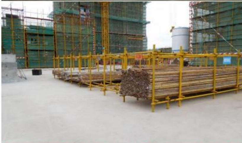
1. 钢筋材料堆放要求做到下有垫，不同规格分类摆放，标识标牌清晰；加气块、木方等材料需做到上盖下垫，做好防雨淋浸泡措施，标识清晰；钢管等周转材料码放整齐、成捆放入吊运装置，标识清晰。
