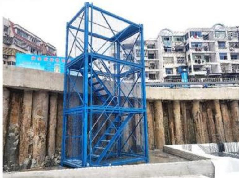
1.上下基坑首选定型化上下通道（右图）；如采用工地现场制作，则要求采用型钢焊接制作，不得采用钢管扣件制作，涂刷黄黑相间警示油漆，踏脚板需有防滑措施。
