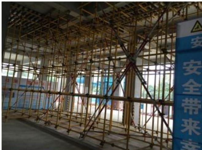
后浇带独立支撑设置规范 (两侧各两排立管+剪刀撑)
