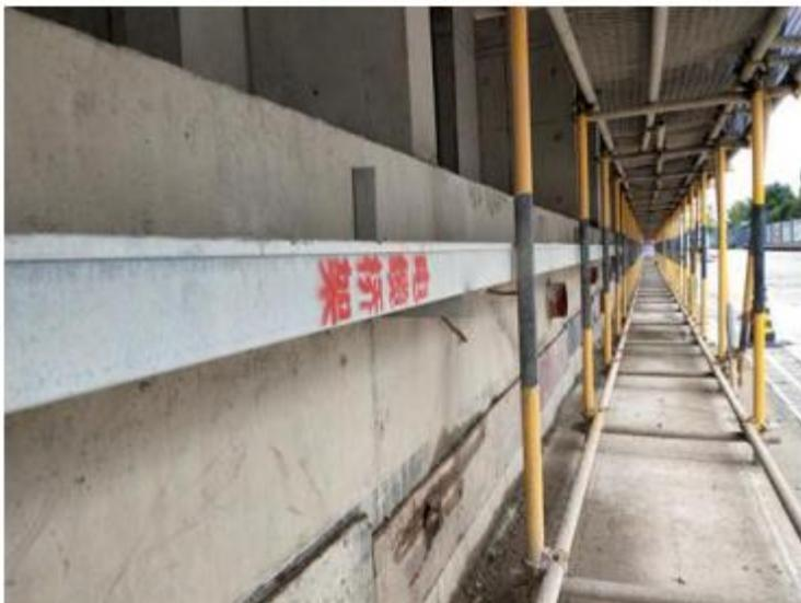
临时电缆侧墙桥架敷设
